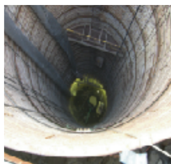
トンネル掘り
