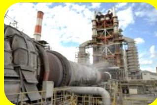
住友大阪セメント(株)赤穂工場のロータリーキルンとプレヒーター
