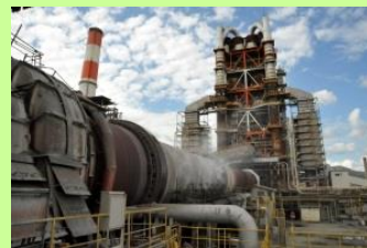
住友大阪セメント(株)赤穂工場の ロータリーキルンとプレヒーター
