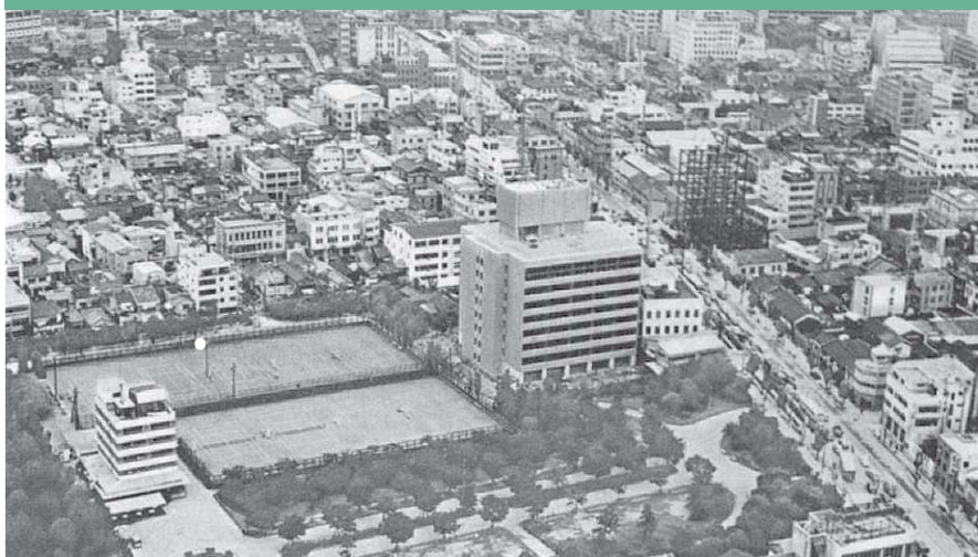
S38年竣工当時の大阪科学技術センタービル
