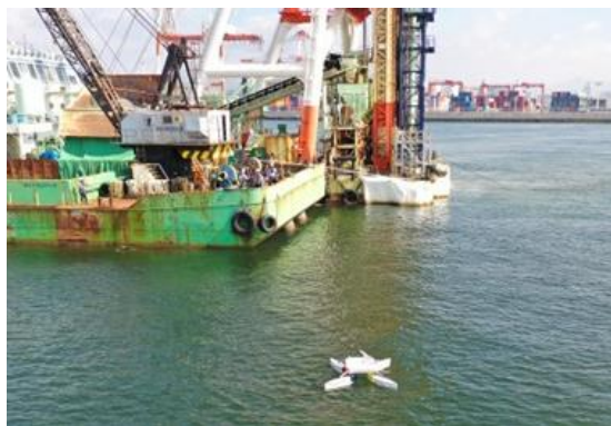
図4 海上工事現場でのデモンストレーション
