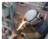
レーザー光浴断機、ロボットアーム、溶けカスを受けるアーム。このセットをモニター越しに遠隔で動かす
