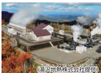
(湯沢地熱株式会社提供) 山葵沢地熱発電所
