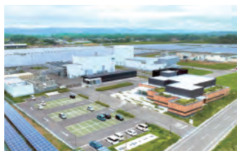
福島水素エネルギー研究フィールド(FH2R) NEDO(国立研究開発法人新エネルギー・産業技術総合開発機構)委託事業
