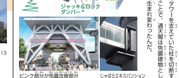
ピンク部分が免震改修部分 じゃばらエキスパンション
